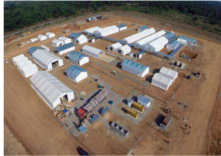
Treatment Center 醫療中心
